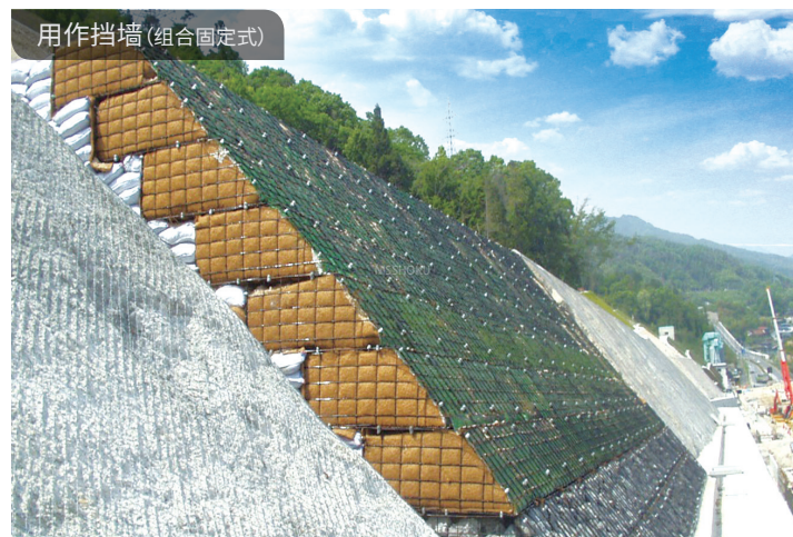
用作挡墙(防沙坝工程)
